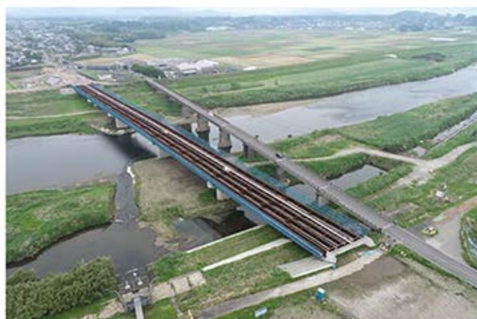
高城山田線 王子橋
