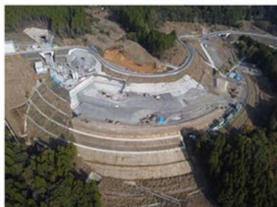
国道447号 真幸工区
