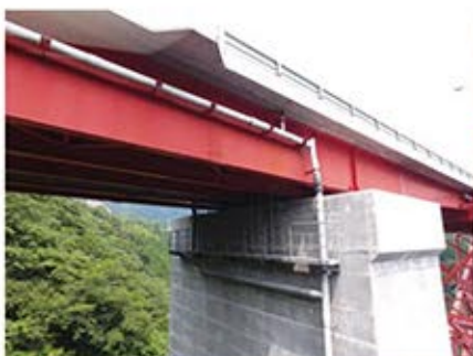
● 国道218号 干支大橋 (延岡市)
