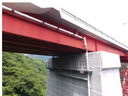
● 国道218号 干支大橋（延岡市）
