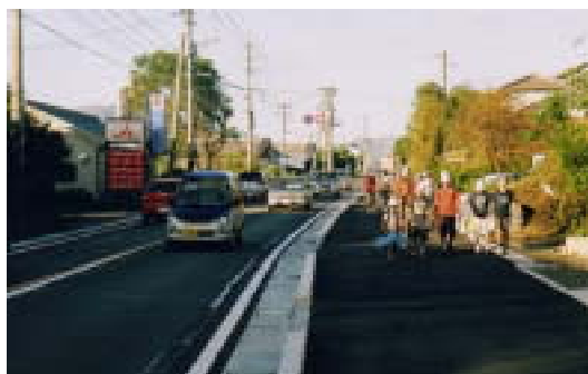
公共交通安全施設事業 ( 国道 2 6 9 号 清武町沓掛 )
