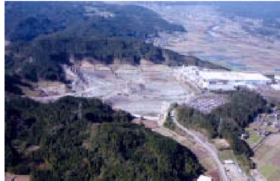
田尻工業団地造成工事
