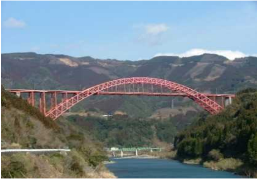
国道218号 干支大橋
