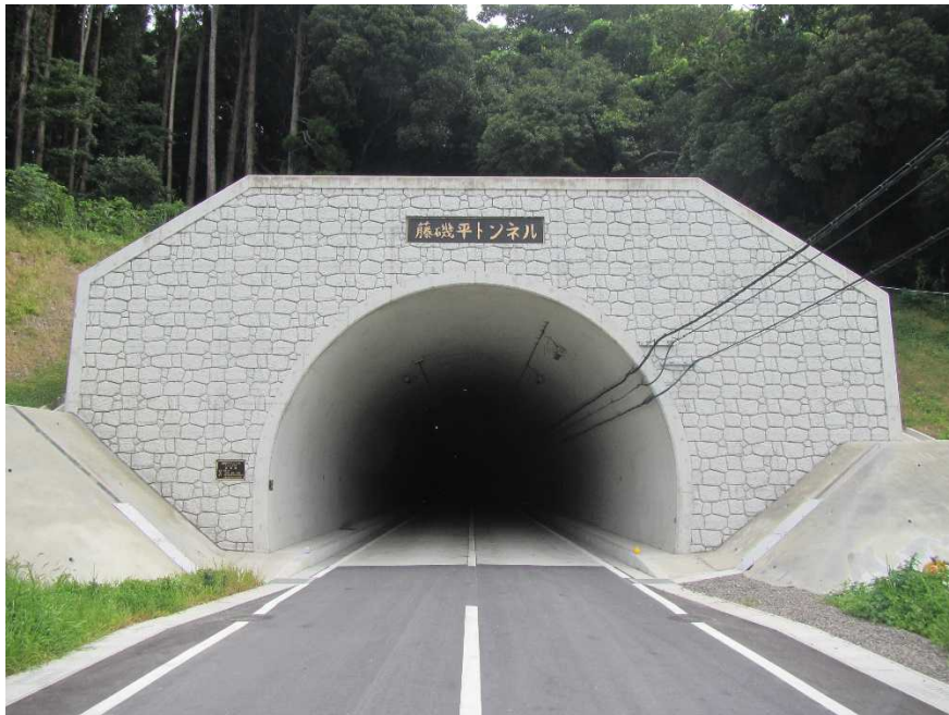
国道448号 藤磯平トンネル
