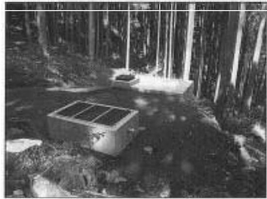
（着手後）ろ過槽及び集水槽を設置
