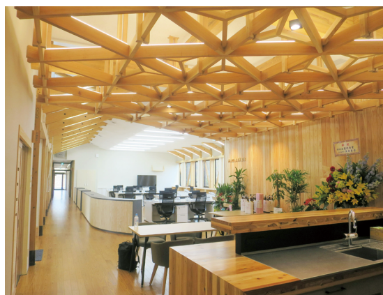
非住宅建築物での木材利用
