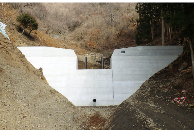
スリットダム
