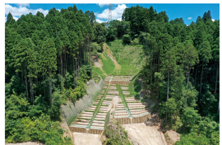
治山施設(木製校倉式土留)
