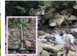
水源調査・分析 簡易な施工
