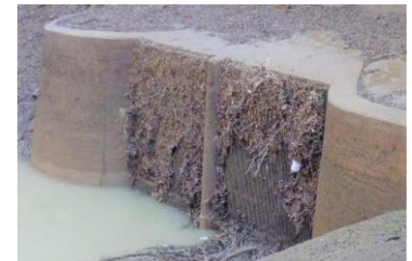
古賀根橋ダム取水口 スクリーン目詰り状況
