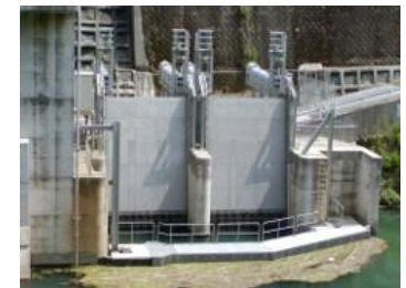
(参考) 猿瀬発電所除塵機
