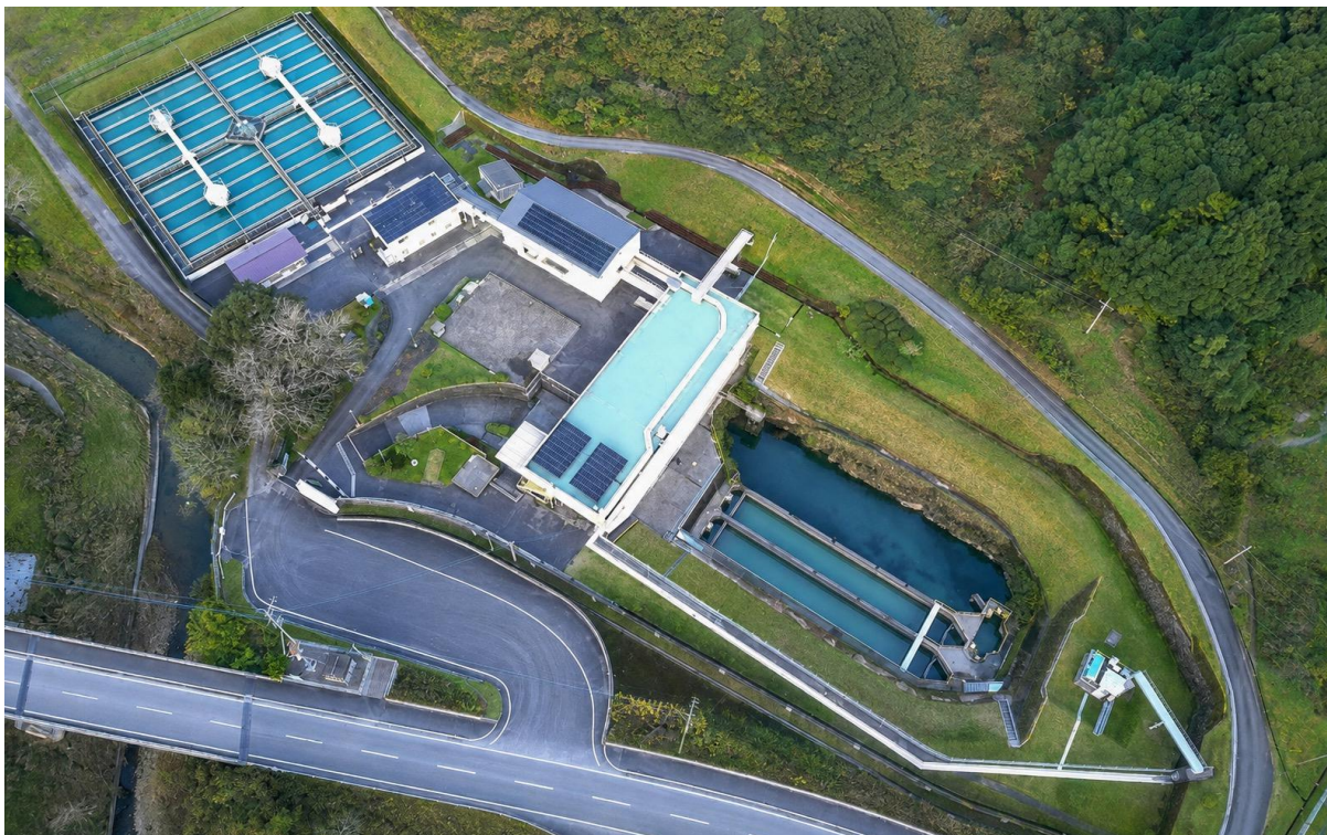
▲工業用水道施設浄水場太陽光発電設備(20kW)
