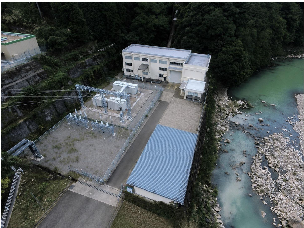
▲ 渡川発電所(12,344kW)
