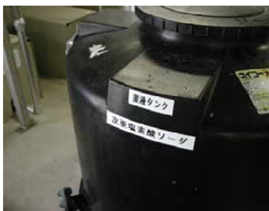
次亜塩素酸ナトリウム溶液タンク 2002/7/27
