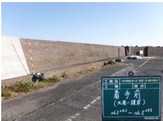
北第一護岸(着手前)
