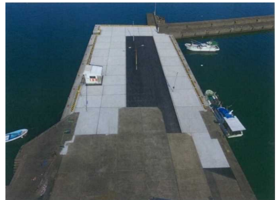
第2物揚場(完成)
