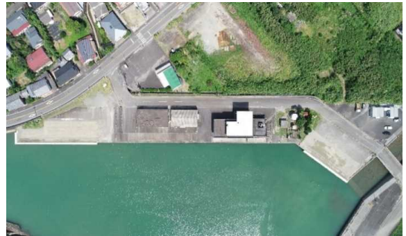
-2m物揚場(完成)
