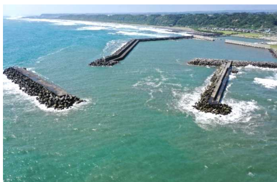
北沖防波堤(着手前)
