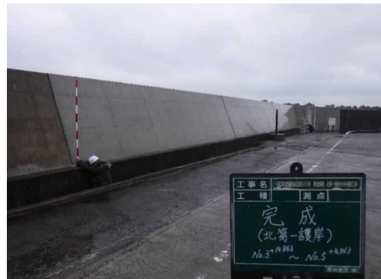
北第一護岸(完成)
