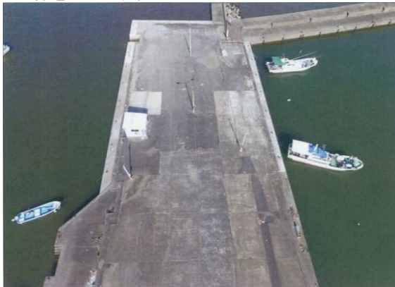
第2物揚場(着手前)
