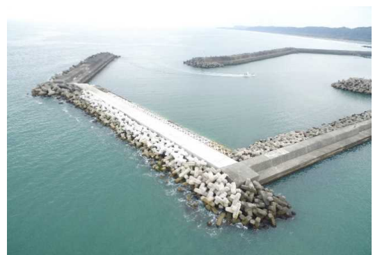
北沖防波堤(完成)
