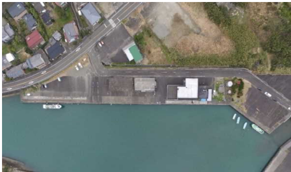
-2m物揚場(着手前)
