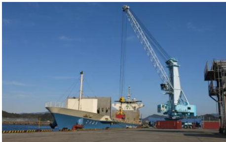
▲コンテナ船荷役状況
