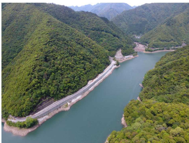
(東郷西都線 松尾工区 施工中)
