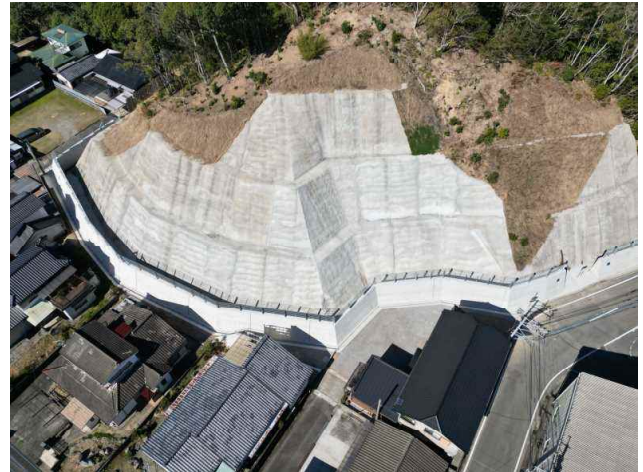
令和6年3月 施工中
