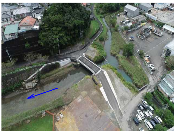
楡津1号橋（R6.3 橋梁完成）
