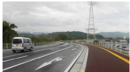
富美山通線整備完了状況
