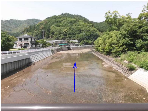
飛川橋下流（護岸完成）
