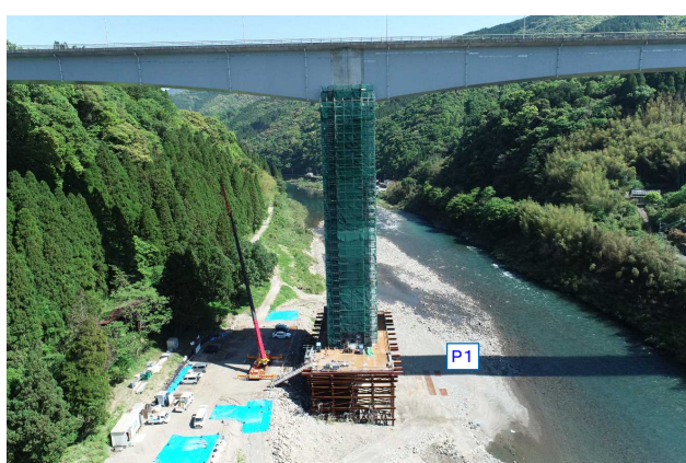
P1 橋脚補強工事
