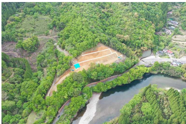
道路状況（妙工区・桑平橋工区）
