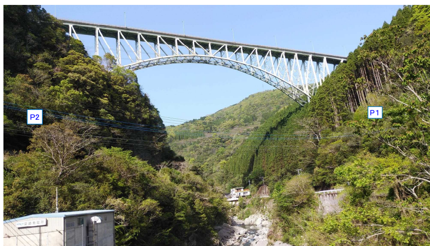
槇峰大橋（下流側から撮影）
