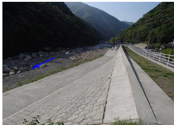
桑平地区（築堤護岸完成）
