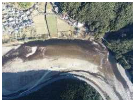
掘削・状況（北川：北川町川内名地区）
