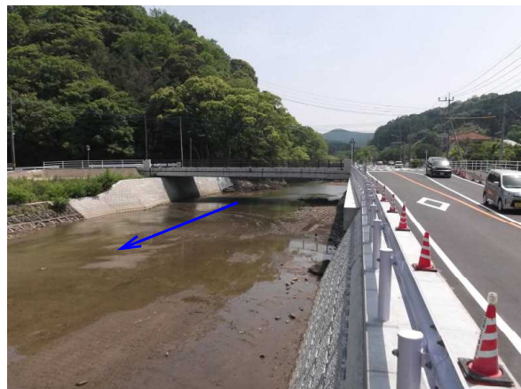
飛川橋（橋梁完成）
