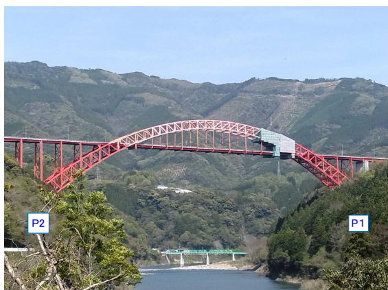
干支大橋（上流側から撮影）
