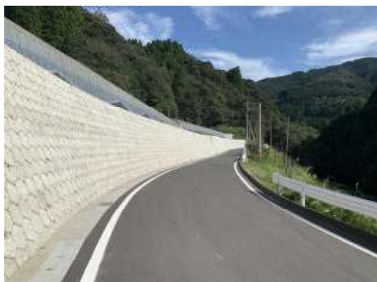
板上曾木線整備状況（三桎工区）
