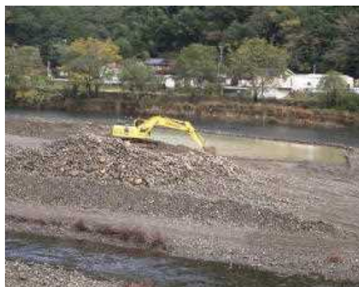
掘削実施状況（北川：北川町川内名地区）
