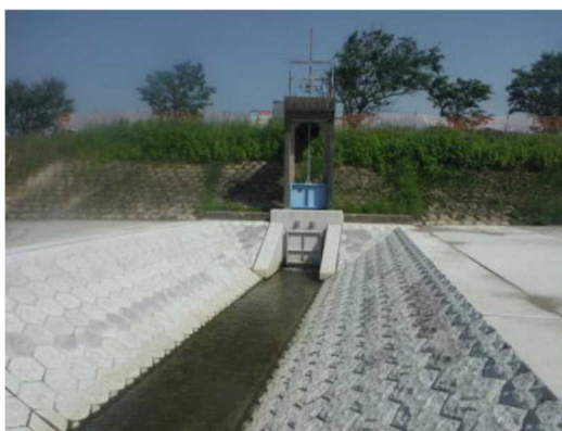
福島川 寺園樋門
