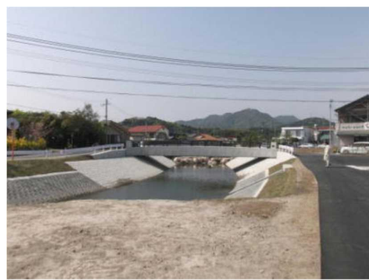
市道ひきじ橋付近
