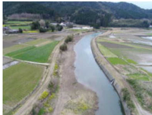
掘削・堤防嵩上げ完了
