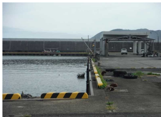
第5物揚げ場（耐震補強）
