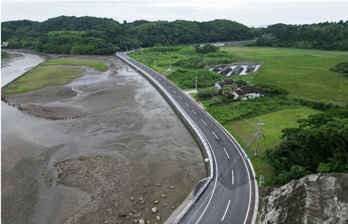
令和5年度完成 一里崎2工区 道路改良工事
