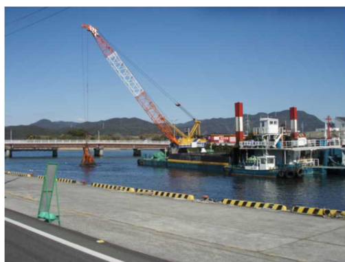
福島港（泊地浚渫状況）
