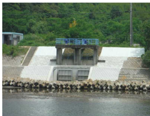
福島川 7号樋門
