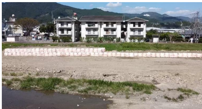
応急復旧完了（土のう設置）
