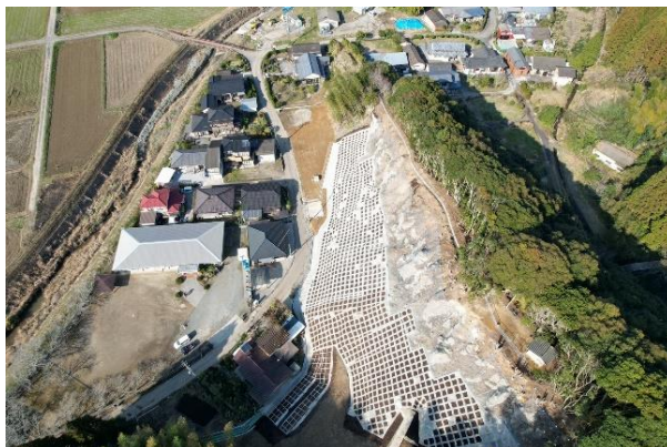
岩下一1地区（急傾斜地対策工）R5完
