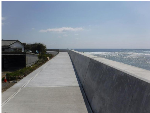
平山海岸（護岸工）H28 完
