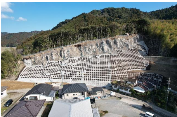
岩下一1地区（急傾斜地対策工）R5完
