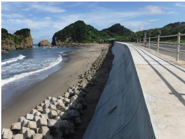
古奥海岸（護岸工）R5完
