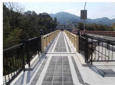
県道下野鹿狩戸線 歩道整備
