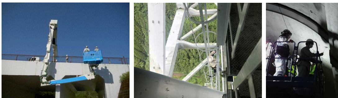
○橋梁やトンネル等の定期点検の様子
