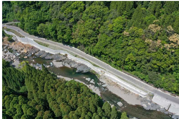
主要地方道日之影宇目線 道路拡幅工事
