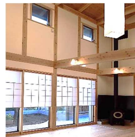
自然通風に配慮した窓
