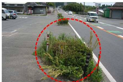
植栽帯を撤去し歩道にする
