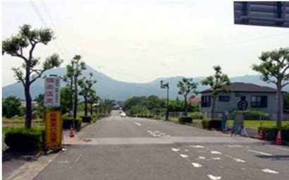
国道223号 植栽状況
