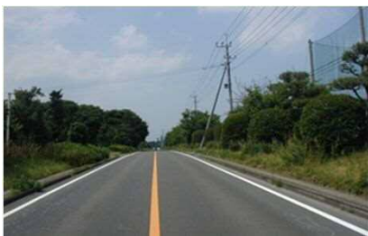
植栽地区（牧の原地区・ 県道都城霧島公園線）
