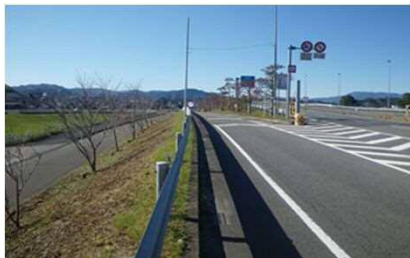
県道延岡インター線 植栽状況
