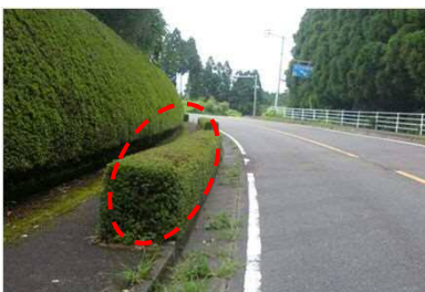
歩道部寄植を撤去する
