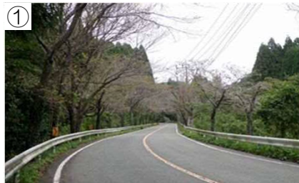
① 植栽地区（川島・国道388号）
