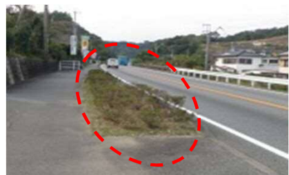
植栽帯を撤去し歩道にする
