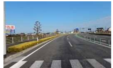
国道327号日向バイパス 植栽状況
