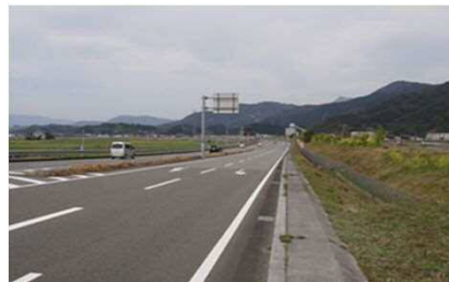
県道延岡インター線 修景状況
