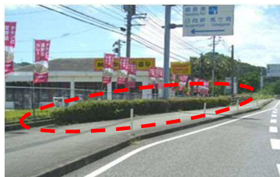
植栽帯を撤去し歩道にする
