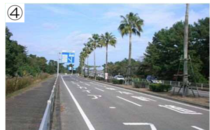
④ 植栽地区（一ツ葉海岸 県道宮崎インター佐土原線）
