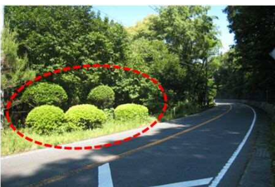
撤去や間引き、自然樹形での維持管理を行う
