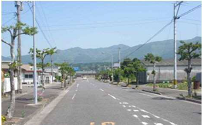
県道えびの高原小田線 植栽状況
