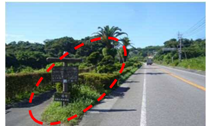
植栽の間引きや撤去、海側の除草や伐開を行う
