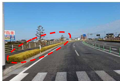
1. の対応例 (国道327号日向バイパス)
