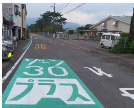
ゾーン30プラス施工例(路面標示) 綾町南麓、東中坪、西中坪、神下地区
