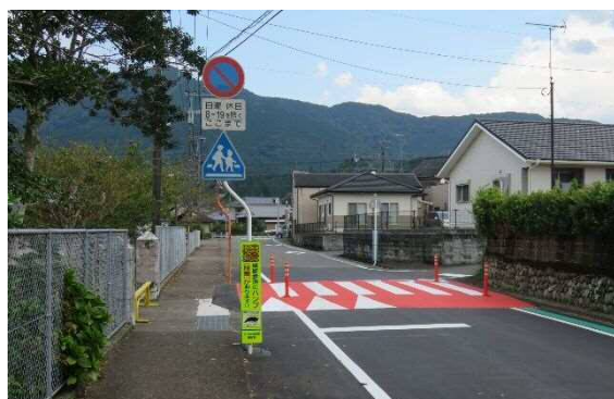
ゾーン30プラス施工例(スムーズ横断歩道) えびの市飯野地区
