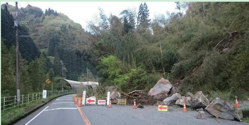
国道 218 号道路災【高千穂町】(平成 28 年熊本地震)
