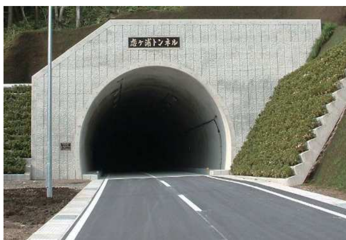
写真 4.2.3 完成した恋ヶ浦トンネル
