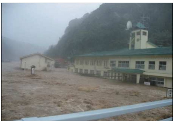
写真4.1.3 浸水状況(日之影町役場) (日之影町:五ヶ瀬川)
