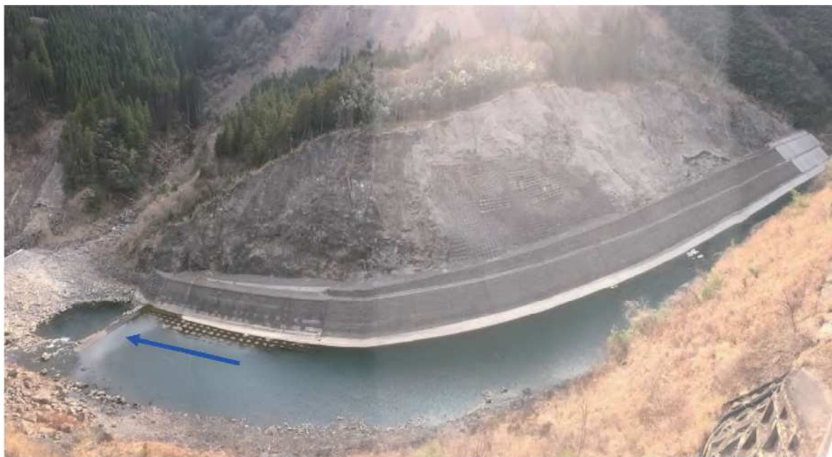
写真4.3.9 工事完了後の状況 (H29.3撮影)
