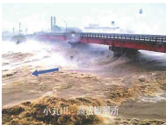
写真4.1.6 豪雨時の高城橋(県道木城高鍋線)の状況 (木城町:小丸川)
