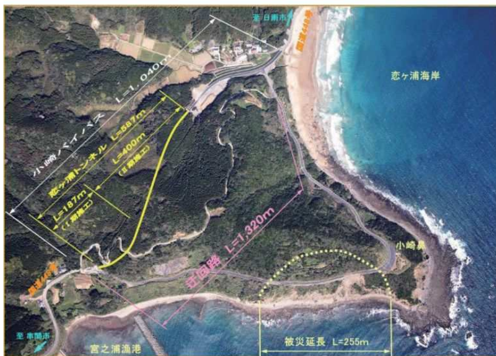
図4.2.2 国道448号小崎バイパス全景
