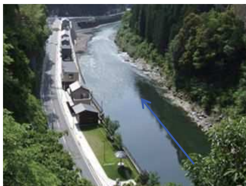
写真4.1.12 対策工事完了後の国道327号の状況 （諸塚村：耳川）
