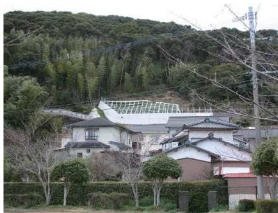
写真4.3.5 竹の上地区災害関連事業完了状況
