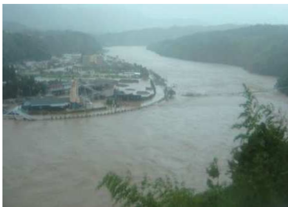
写真4.1.17 浸水状況(旧北方町役場) (延岡市北方町:五ヶ瀬川)
