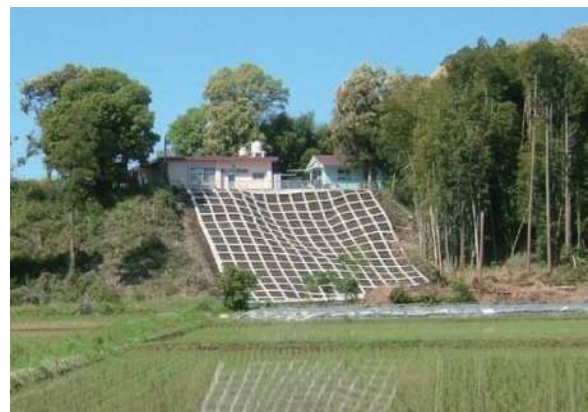
写真4.2.7 朝食地区災害関連事業完成状況
