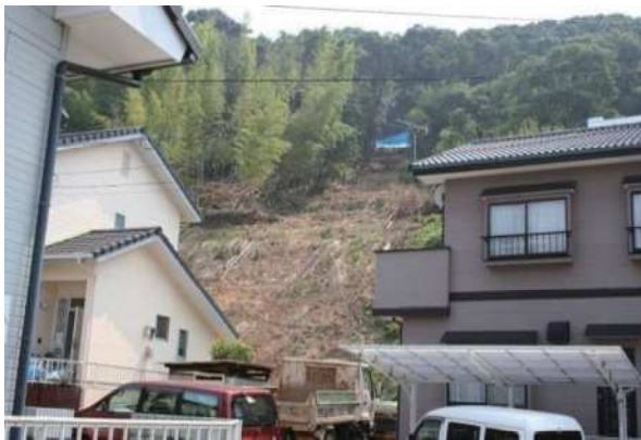
写真4.3.3 竹の上地区被災状況
