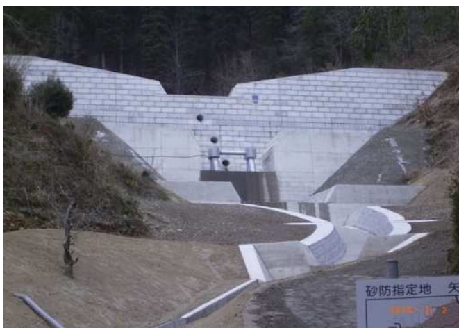
写真4.2.9 矢左右谷川災害関連事業完成状況
