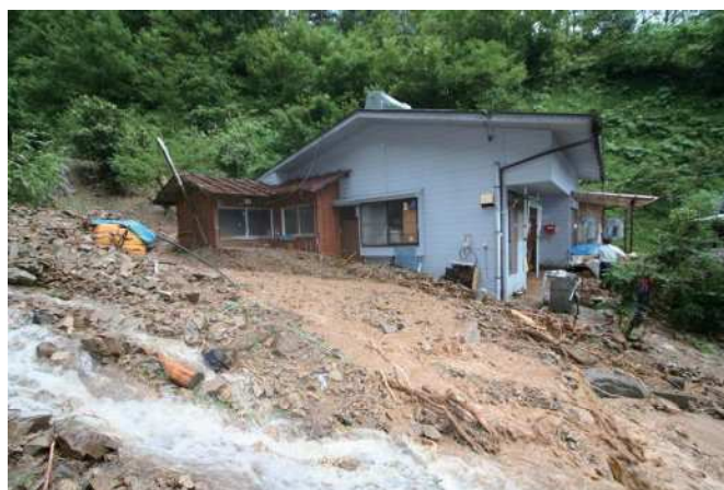
写真4.2.8 矢左右谷川被災状況
