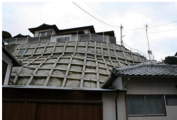
写真4.3.2 八幡地区災害関連事業完成状況
