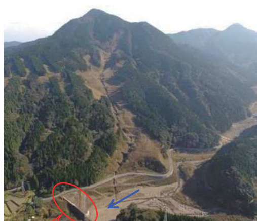
写真4.1.14 対策工事完了後の状況 （宮崎市田野町：別府田野川）
