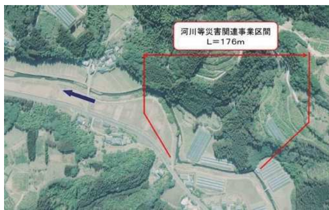
写真4.3.7 湯上川災害関連事業全景
