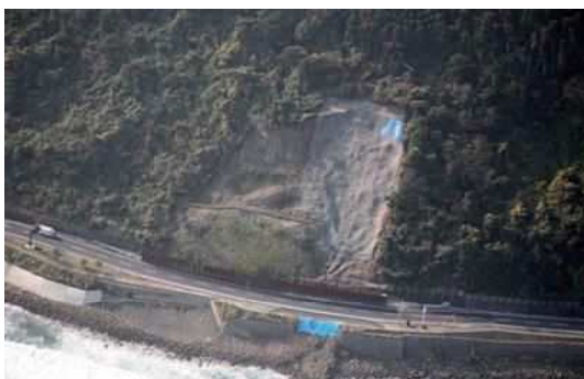
写真4.4.4 応急復旧完了後
