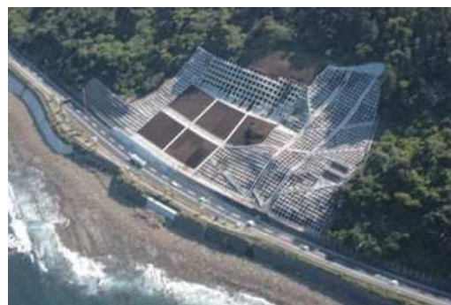
写真4.4.5 本復旧完了後
