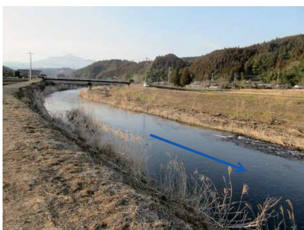
写真4.5.10 堰撤去箇所の状況（上流川）
