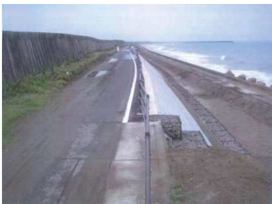
写真4.6.10 復旧状況（起点側から望む）
