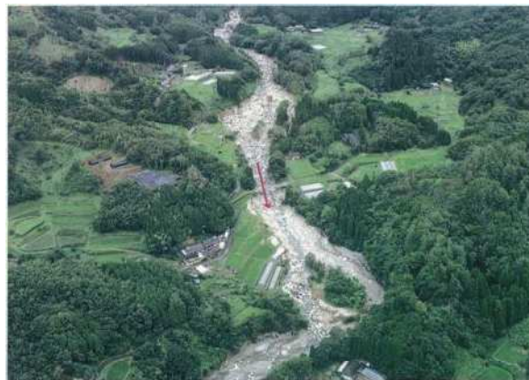
写真4.3.12 網の瀬川被災状況 (鹿川地区)
