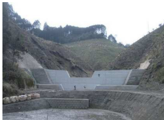
写真4.5.15 渡司川災害関連事業完成状況
