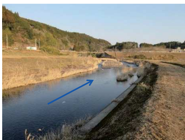
写真4.5.11 堰撤去箇所の状況（下流川）完成写真
