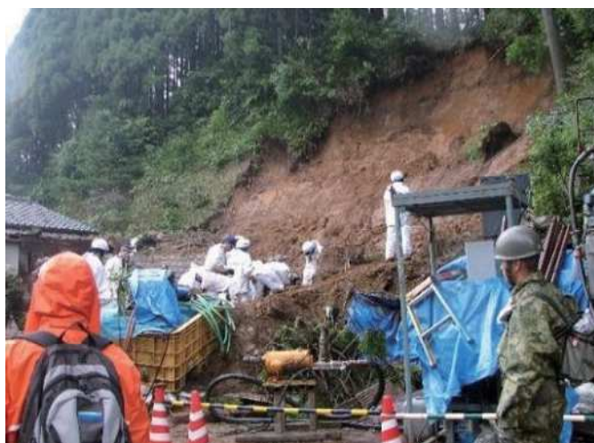
写真4.5.1 裏山のがけ崩れ (都城市高野町)
