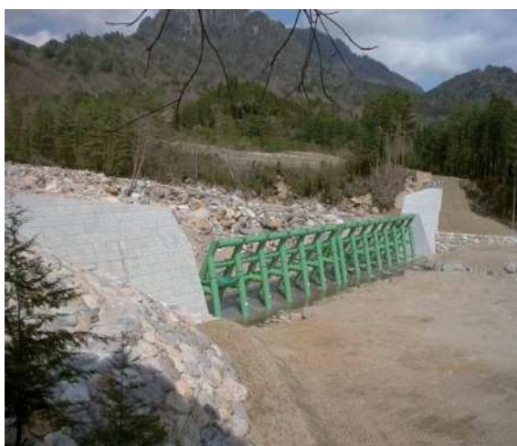
写真4.3.15 災害関連緊急砂防堰堤
