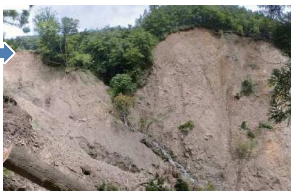
写真4.6.4 山腹崩壊頭頂部
