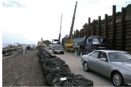
写真4.4.3 応急復旧状況
