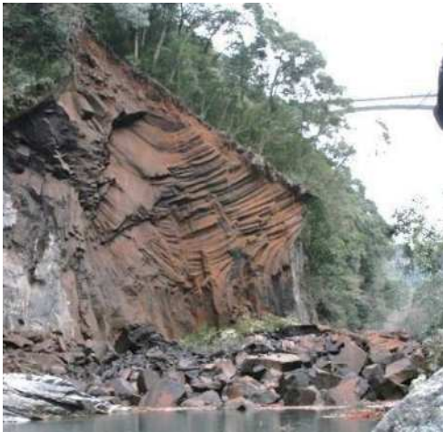
写真4.6.1 柱状節理の崩落状況
