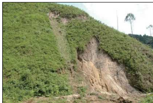
写真4.5.14 渡司川被災状況
