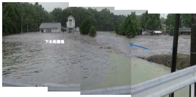
写真4.8.2 下水処理場の被災状況
