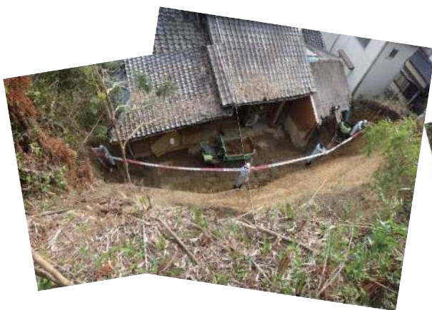
写真4.10.7 稲葉崎第2-1地区被災状況
