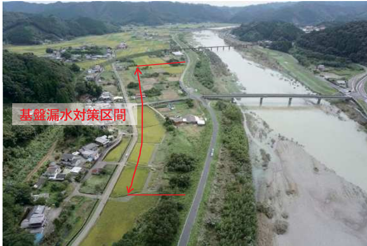
写真 川坂地区基盤漏水対策区間
