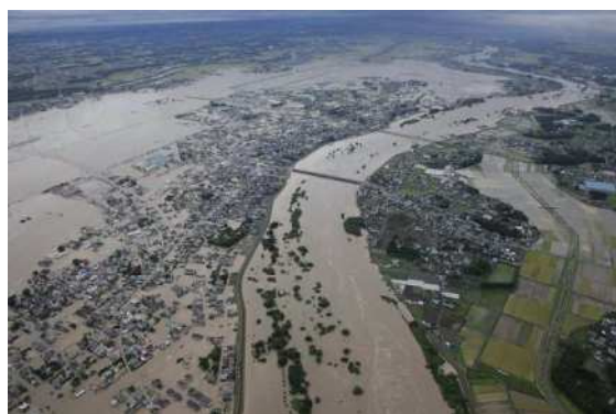
写真① 鬼怒川堤防決壊 国土交通省東北地方整備局HP
