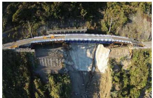
写真 4.9.3 仮橋設置完了
