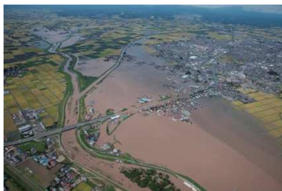
写真② 渋井川堤防決壊 国土交通省東北地方整備局HP
