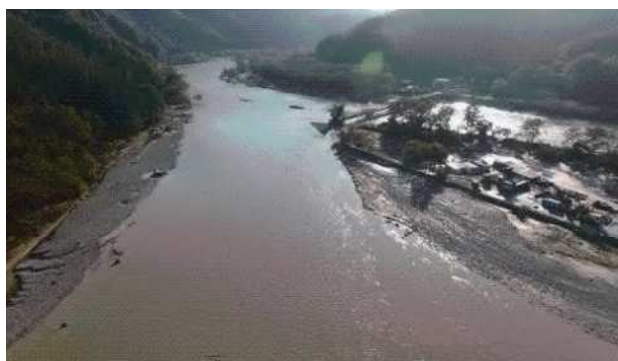
写真① 氾濫した小本川の被災箇所 国土地理院HP
