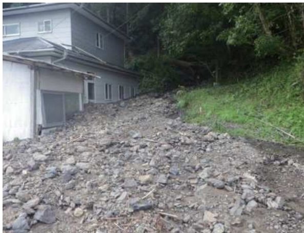
写真4.10.4 北小崎谷川被災状況
