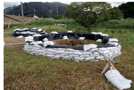
写真 釜段工法の様子
