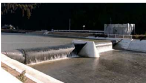
写真4.7.5 浜山井堰完成
