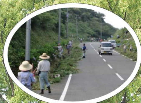
道路の除草作業
