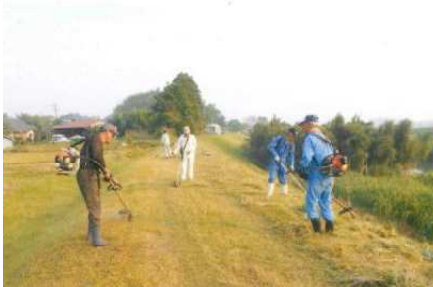
▲県民による堤防の草刈り作業・萩原川（都城市）
