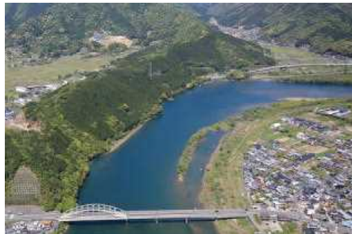
▲多自然川づくりの事例・北川（延岡市） 人工的にワンド（入り江・写真中央）を造成し、 水生生物が棲みやすい環境を確保している。
