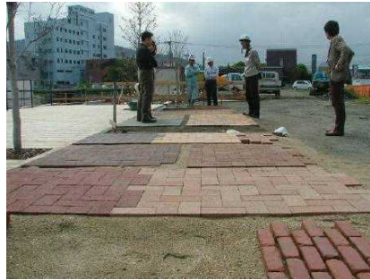
▲整備内容を試験施工により確認（日南市）
