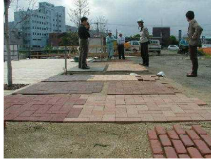
▲整備内容を試験施工により確認（日南市）
