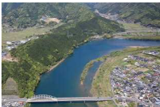
▲多自然川づくりの事例 北川（延岡市） 人工的にワンド（入り江・写真中央）を造成し、水生生物が棲みやすい環境を確保している。
