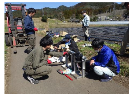
【散水器具設置の様子】
