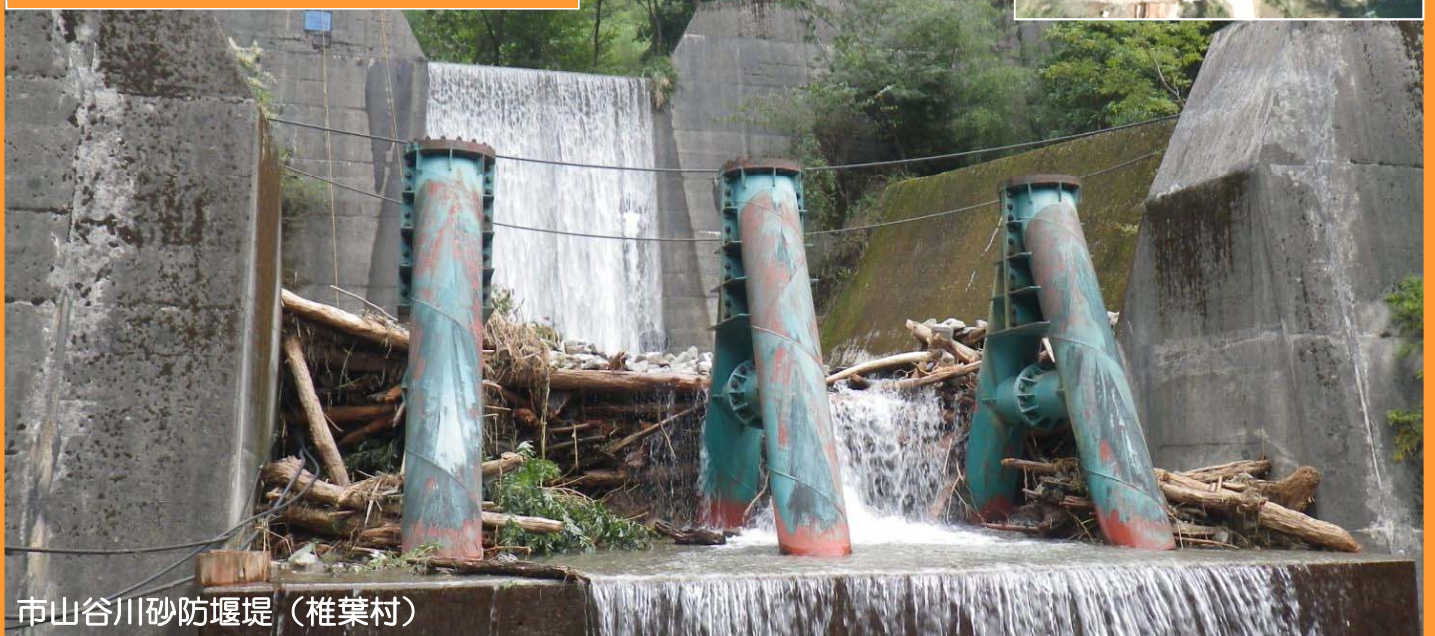
土砂・流木捕捉状況
