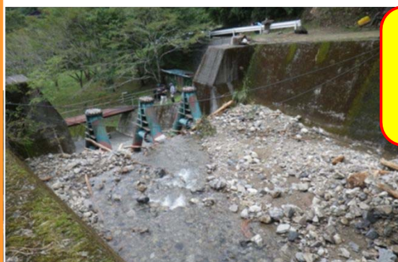
土砂・流木捕捉状況
