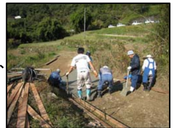
直営施工による農道舗装 (都農町 鼓集落)
