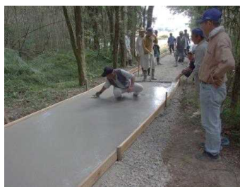
避難路の整備
