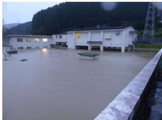
令和 4 年 9 月の被害状況 (県企業局工業用水道浄水場: 日南市東郷町山陰)
