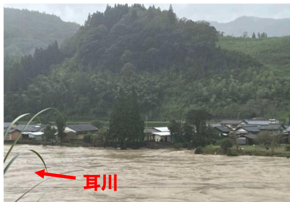
令和 4 年 9 月の被害状況(和田地区)
