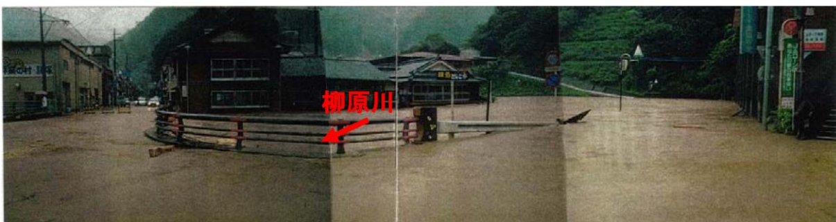
平成9年9月の被害状況(諸塚地区)
