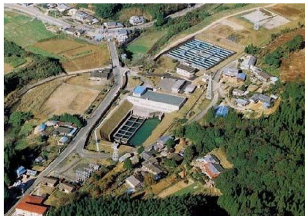
県企業局工業用水道浄水場
