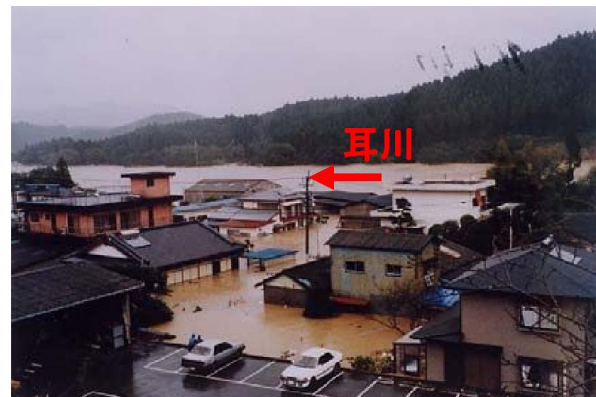
平成9年9月の被害状況(小野田地区)
