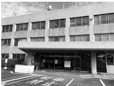
小林総合庁舎(正面)(監査人撮影)
