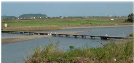
写真：福島潜水橋
