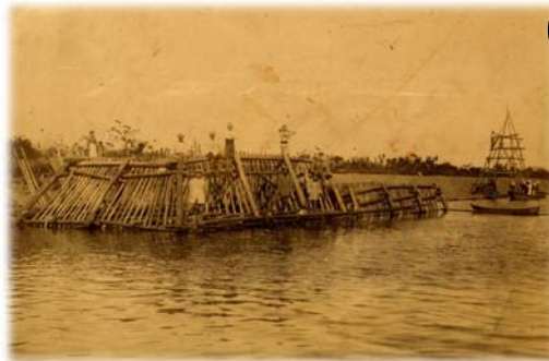
写真：水制工の組み立て風景
