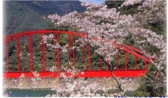
写真：一ツ瀬11橋
