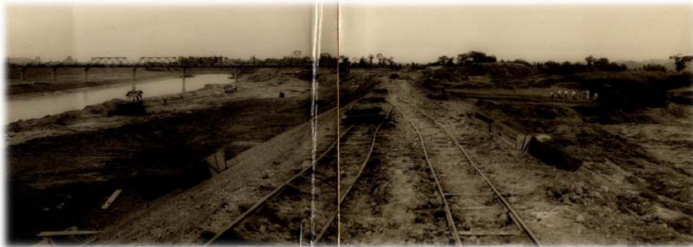
写真：堤防の上に設置されたトロッコ線路
