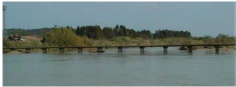
写真：柳瀬潜水橋
