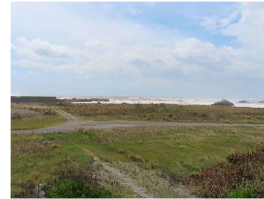
令和2年9月7日出水後の状況
