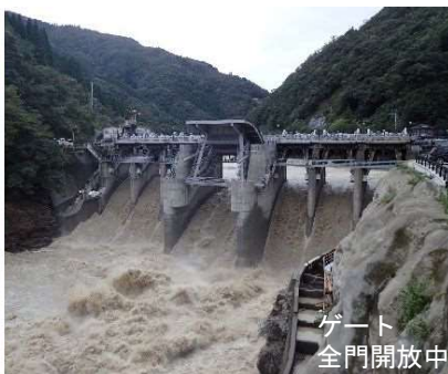
山須原ダム（台風最接近から約1日後）
