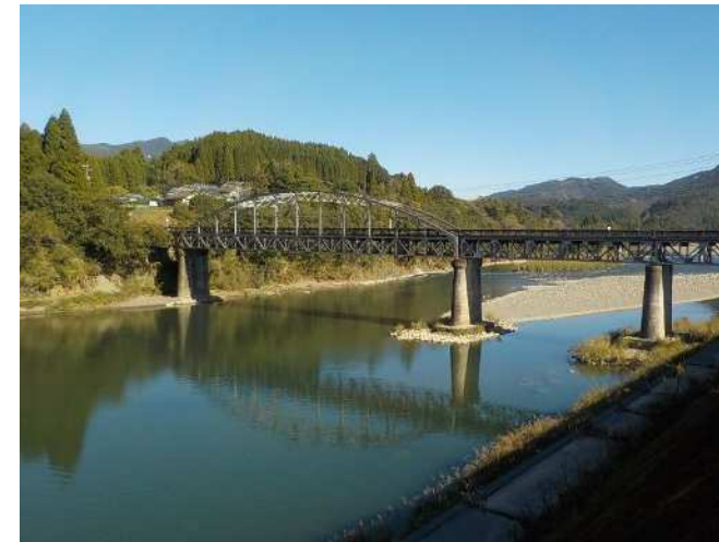
八重原橋：令和5年11月14日撮影
