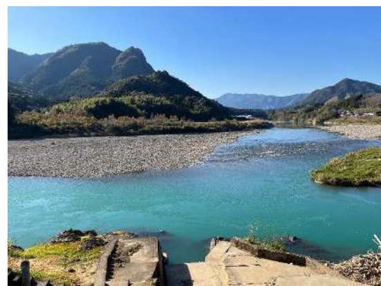
工業用取水口付近（11k320）：令和4年12月撮影
