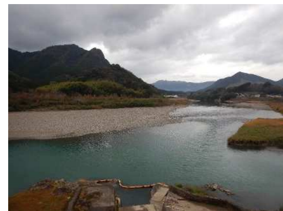
工業用取水口付近（11k320）：令和5年12月撮影
