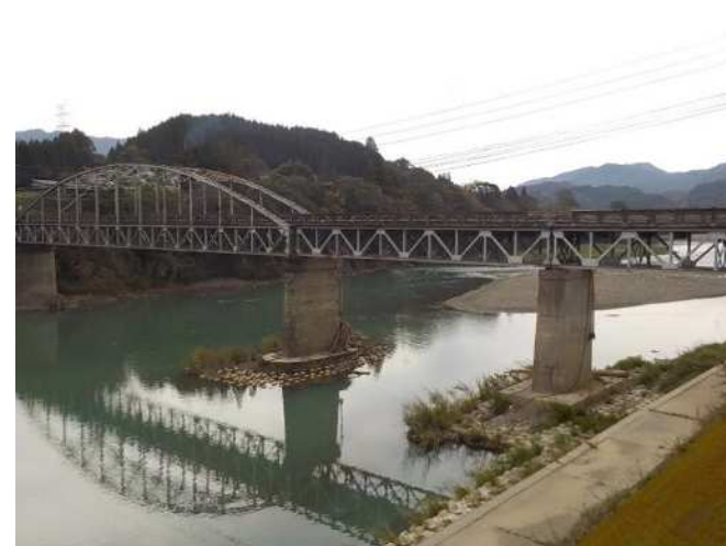
八重原橋：令和4年11月17日撮影
