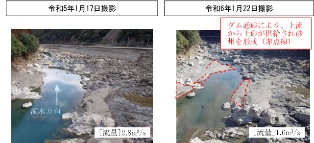
写真 河川状況 (西郷ダム下流約1.2km地点(立石橋から下流に向けて撮影))
