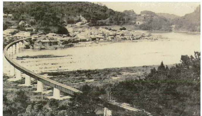
完成した鉄橋
