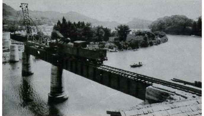
工事中の鉄橋
