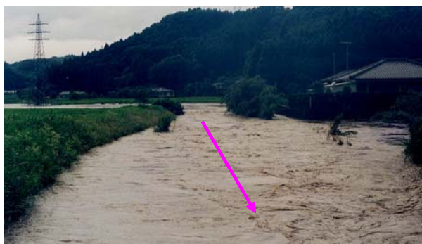
平成5年6月浸水状況(奥の下橋上流)
