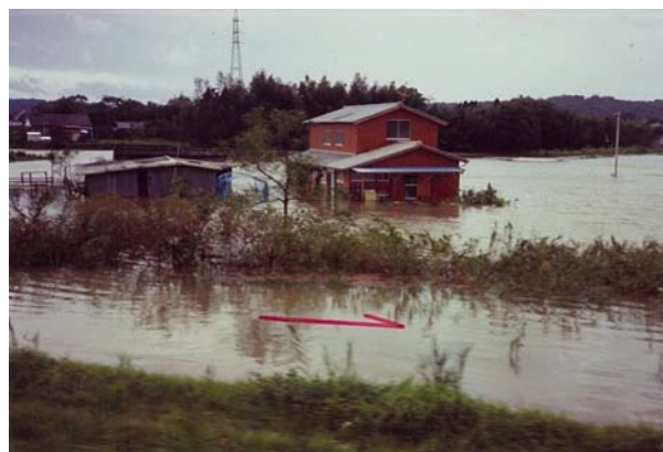
平成5年6月浸水状況(光音寺橋下流)
