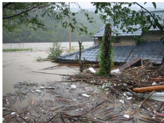
■山下地区の浸水状況(宮崎市)
