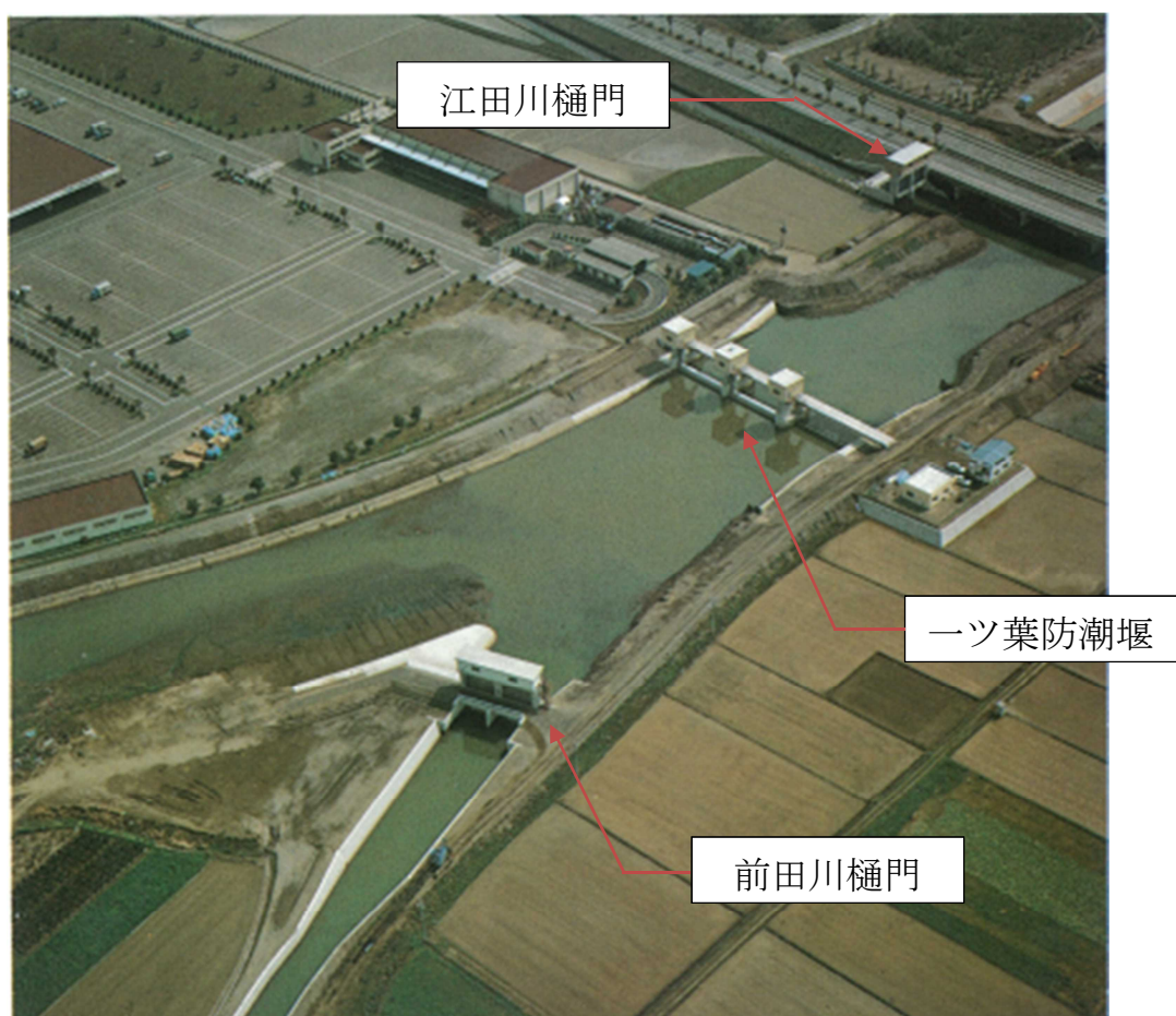
一ツ葉防潮堰・江田川樋門・前田川樋門 (写真 ⑦)
