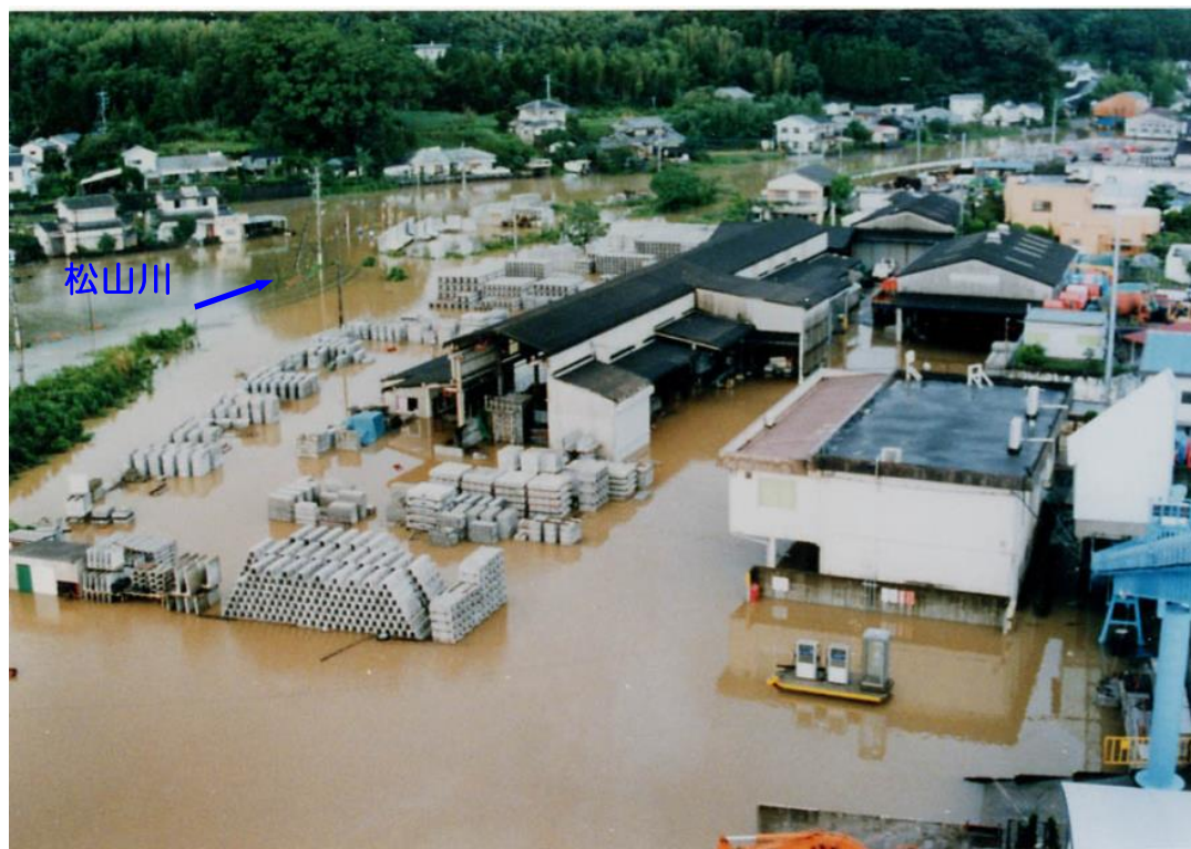
平成9年9月洪水による支川松山川下流部の被災状況
