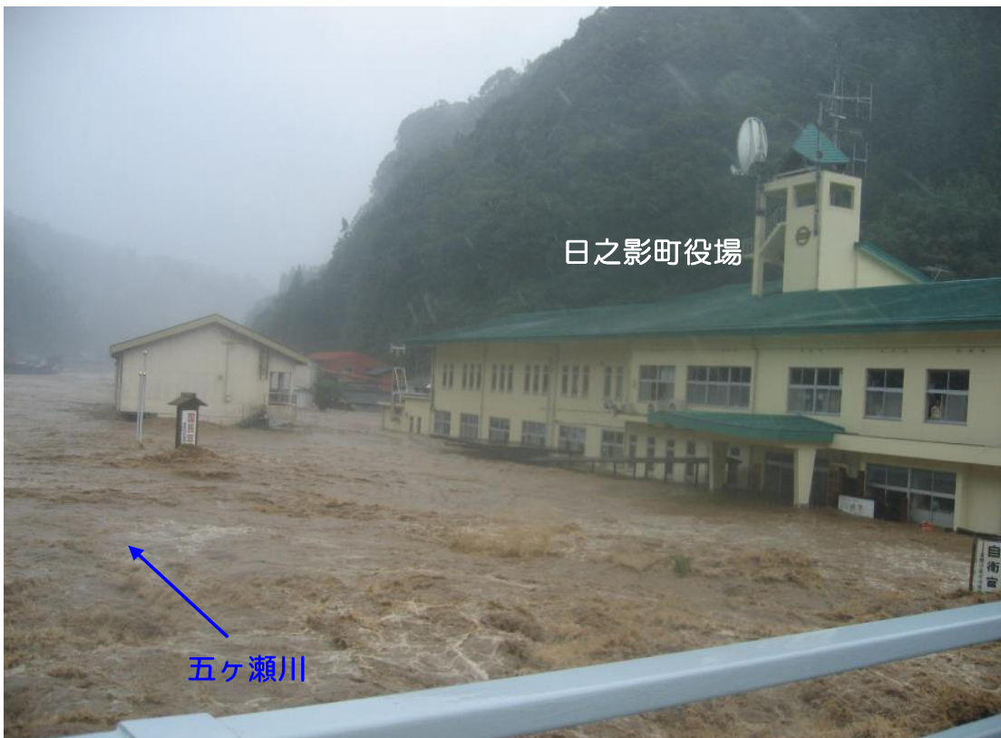
平成 17 年 9 月洪水による五ヶ瀬川本川沿い日之影地区の被災状況
