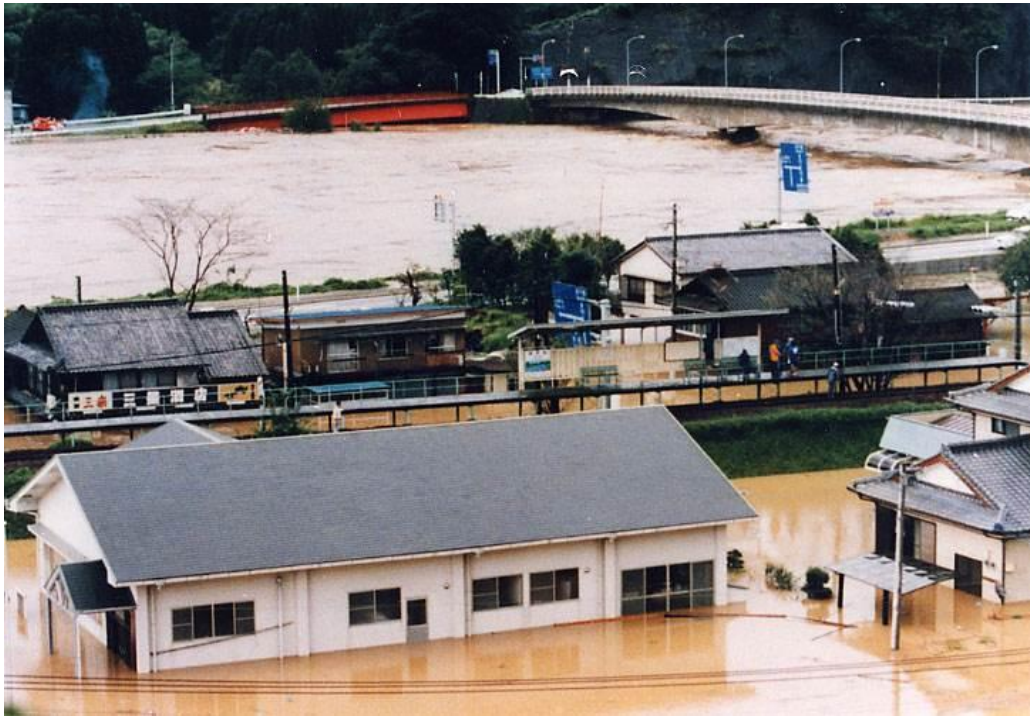
平成 5 年 8 月洪水による五ヶ瀬川本川沿い細見地区 ほそみ の被災状況
