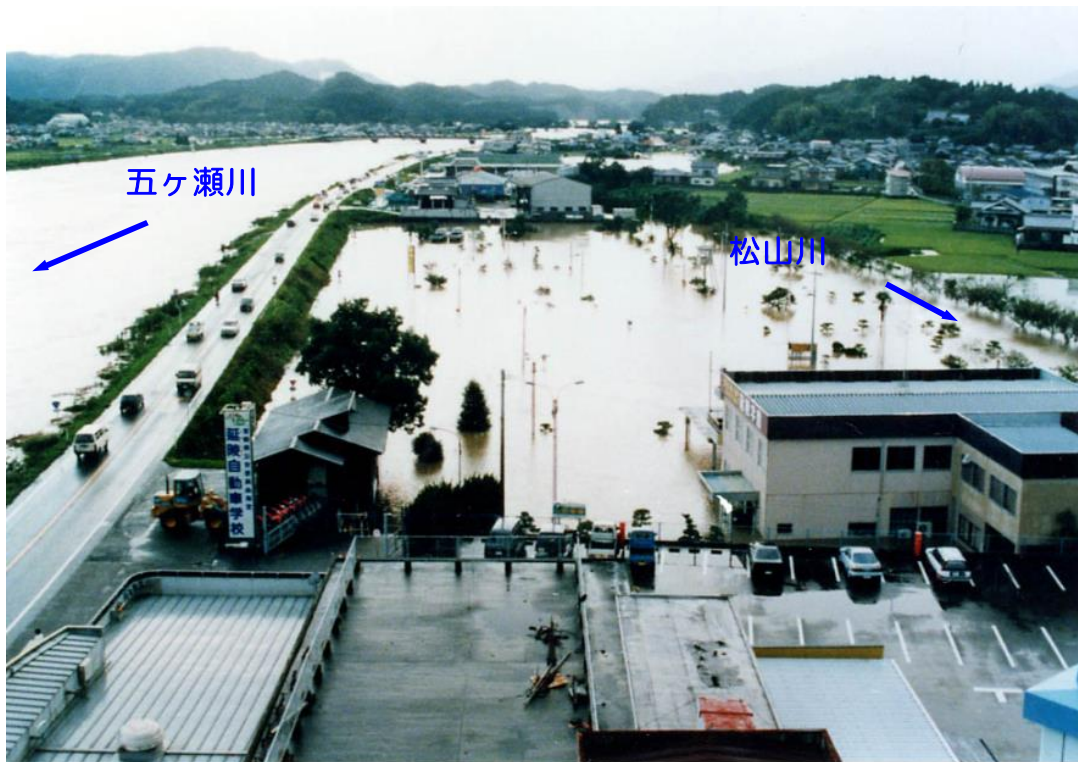
平成9年9月洪水による支川松山川中流部の被災状況
