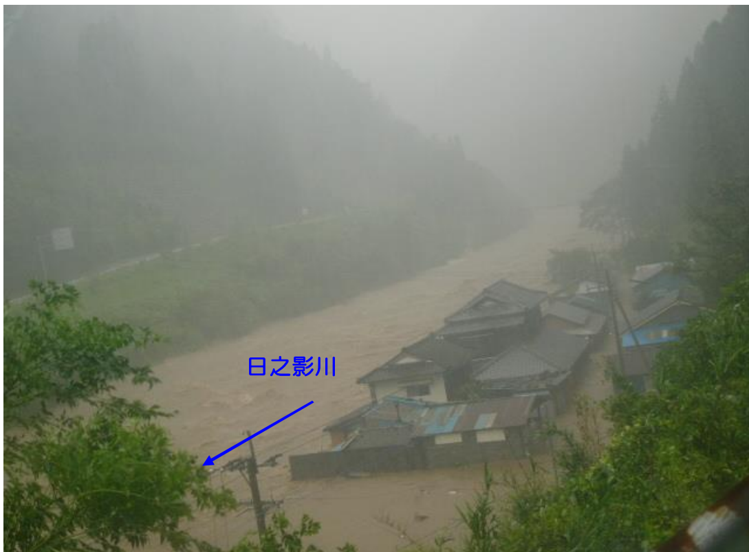
平成 17 年 9 月洪水による支川日之影川沿い日之影地区の被災状況
