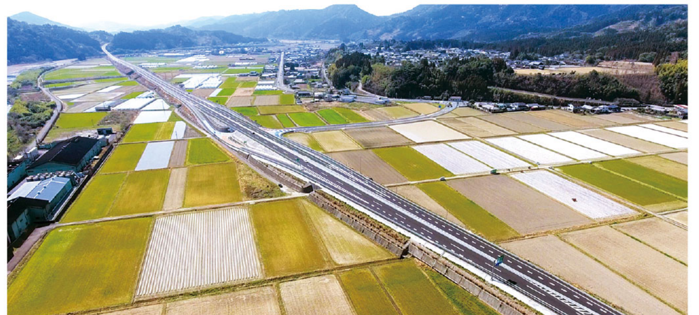
東九州自動車道 日南北郷IC (令和5年3月撮影)
