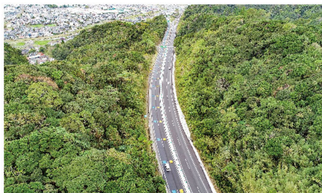
鹿児島県 隼人道路4車線化
