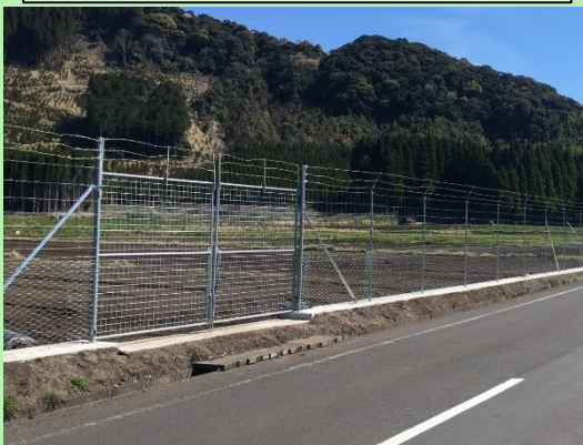
張りコンクリート施工した侵入防護柵
