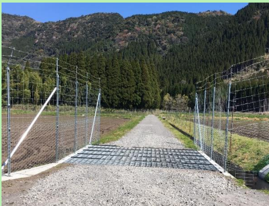
ほ場入口に設置したグレーチング
